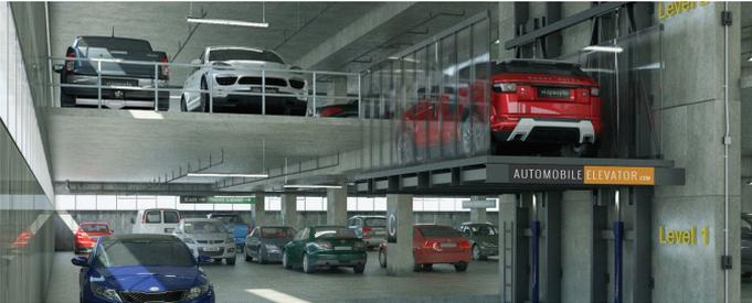
Figura 8. Ejemplo de elevadores de estacionamiento. Foto: <http://thangmayhexacorp.com/>
